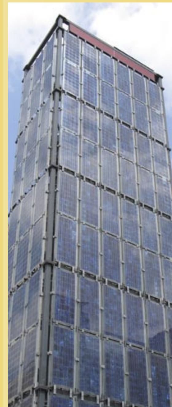
På Vesterbro er der opført et trappetårn med solpaneler som klimabeskyttende flader – et eksempel på de mange muligheder der er for en utraditionel brug af solceller
