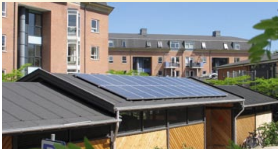
Østerfælled, solceller til drift af komposteringstromle
